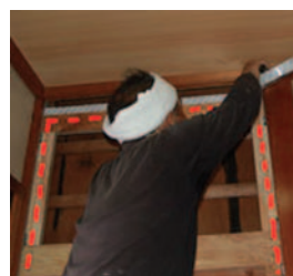
先端技術で生まれた両面テープを施工しているところ
